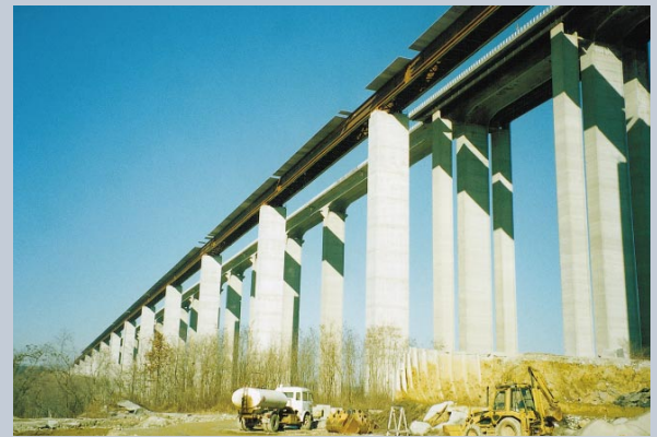
Stura di Demonte viaduct, Italy
